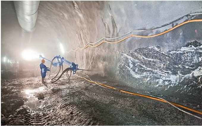
Abb. 1: Erstarrungsbeschleuniger im Tunnelbau (Foto: DI Mayr Roland, www.master-builders-solutions.com , 28.06.2021)
