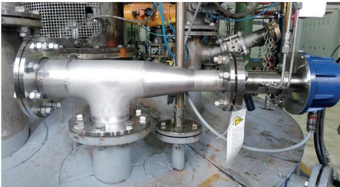
Abbildung 1: Waagrecht verbaute Sonde (eigenes Foto).
